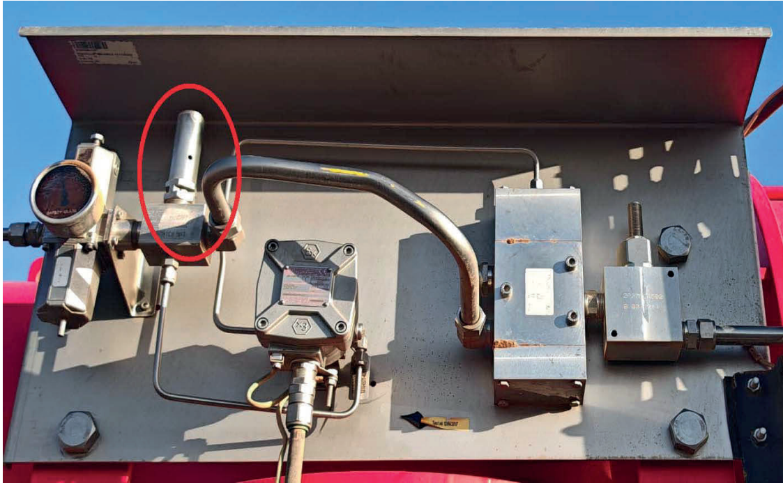
Valvola di sicurezza installata su un attuatore Oil & Gas
